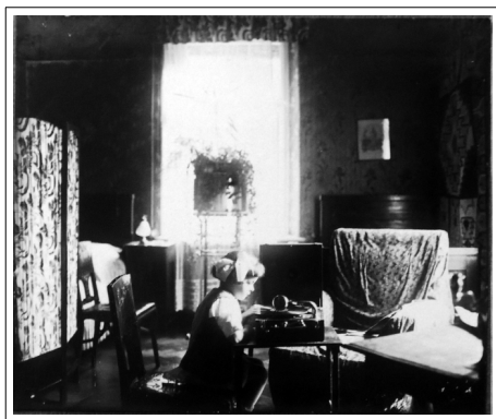
Wnętrze starego dworu Krzysztofowiczów □ w Żałuczu, 1930
